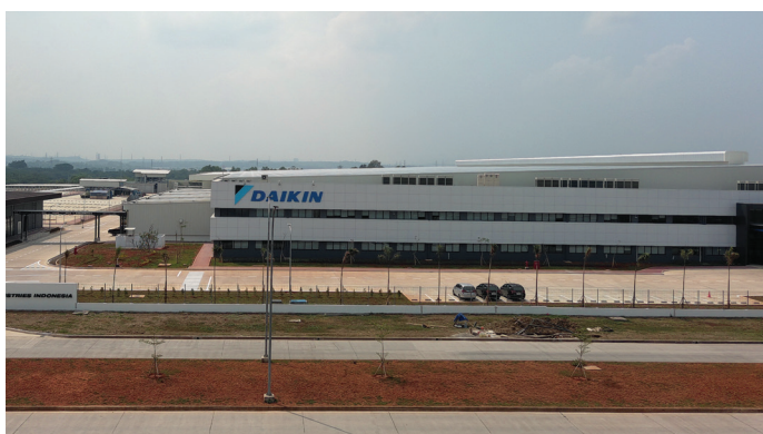
Pabrik Daikin Indonesia - Jawa Barat
